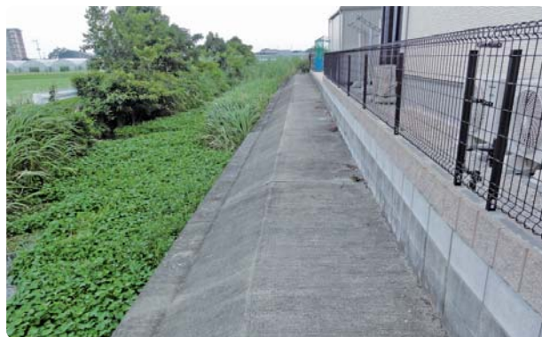
▲管理用通路を設けた例
