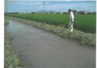
異常気象時の対応 (洪水警報後の点検)
